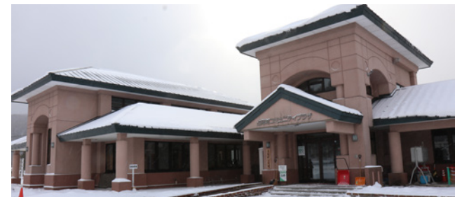
▲平成6年 占冠村コミュニティプラザが開設。様々な用途で幅広く活用されています。
