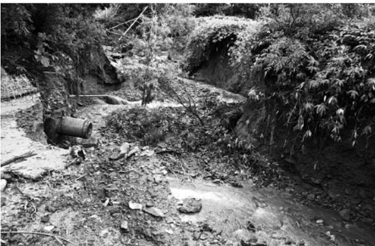
配管がむき出しになり崩壊した道路（村道トマム東1号線）
