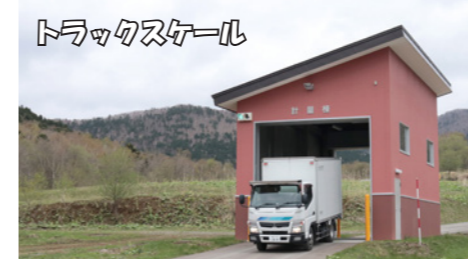
▲ごみを積んでいる車両ごと重量を計測。積んだ状態と降ろした後の計2回計測し、その差によって搬入されたごみの重量を算出します。
