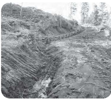
作業道補修の状況
