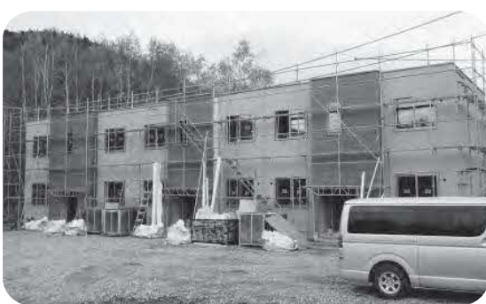
建設中の民間共同住宅（トママ）
