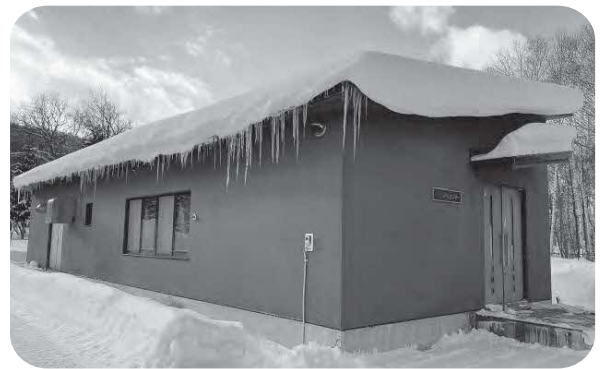
トママ下水処理場
