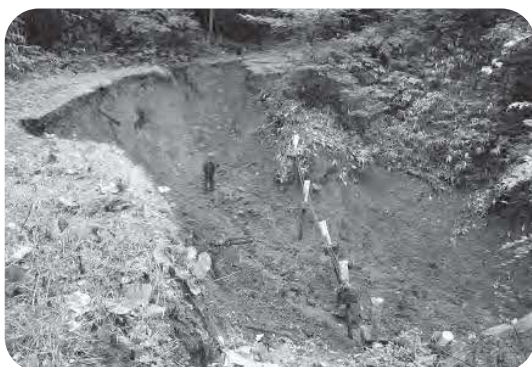
三角山林道被害
