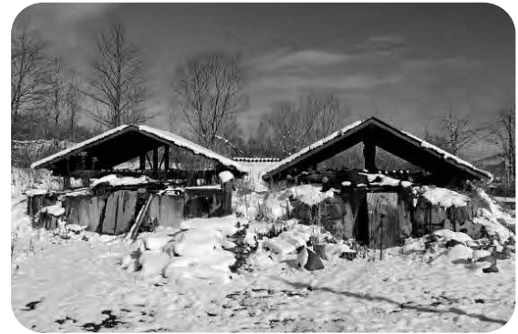
解体前の炭焼小屋
