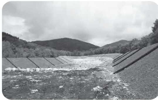
嵩上げされた最終処分場
