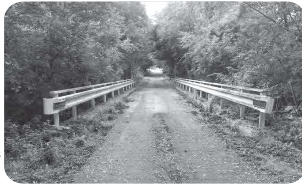
中トマム13線橋
