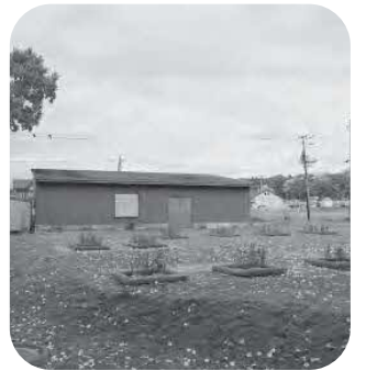
中央浄化センター
