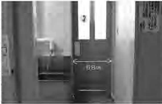
車いすでは利用できない中学校のトイレ
