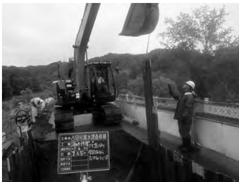
占冠地区水道管の漏水修繕
