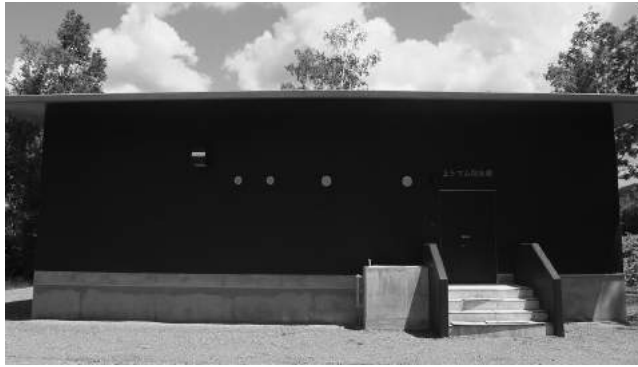
上トママ地区ポンプ場
