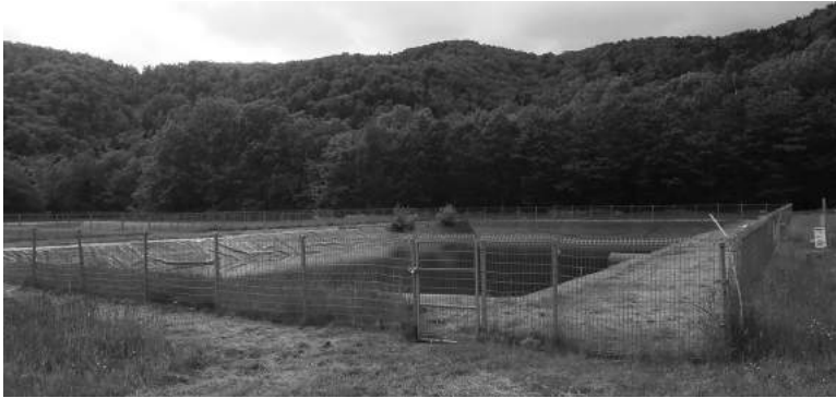
一般廃棄物最終処分場
