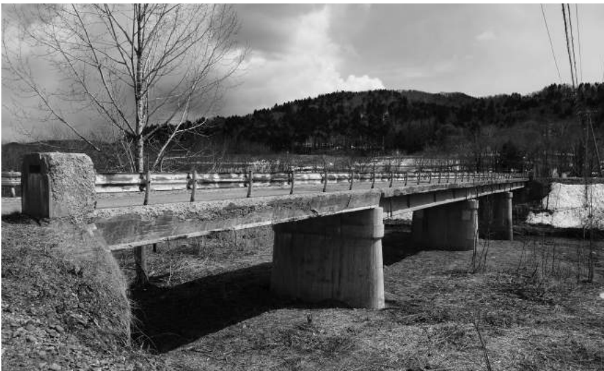
本年度上部工改修工事が予定されている宮下橋
