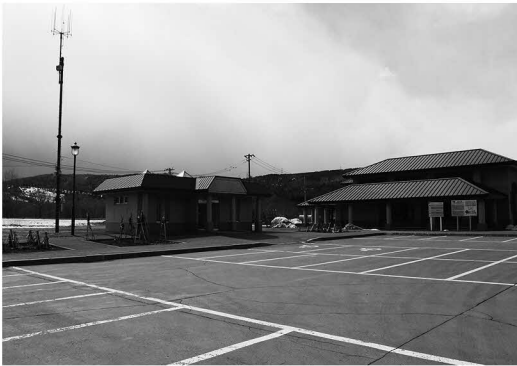
監視カメラが設置される道の駅
