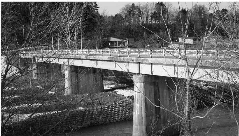
本年冬から下部工事はじまる宮下橋
