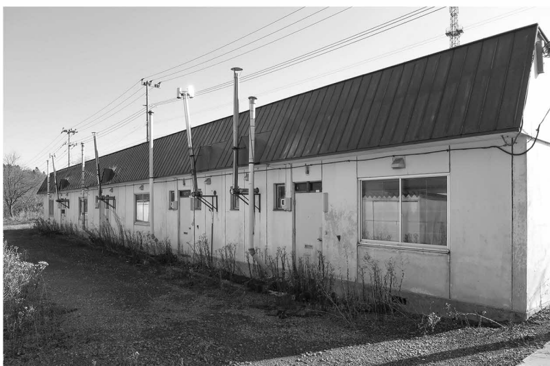
老朽化のため解体が予定される占冠市街公営住宅
