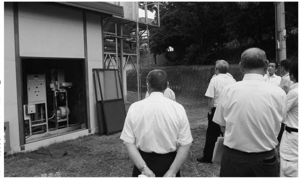
「きのくに中津荘」の木質パウダーボイラー
