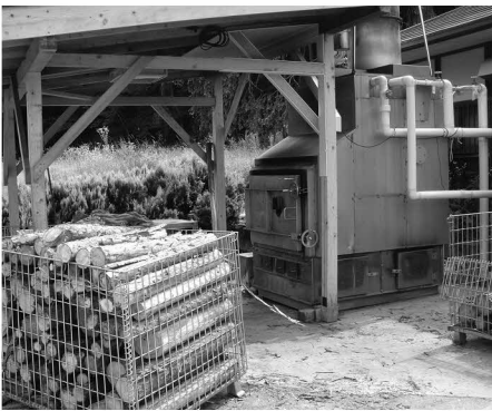
花白温泉の薪ボイラー
