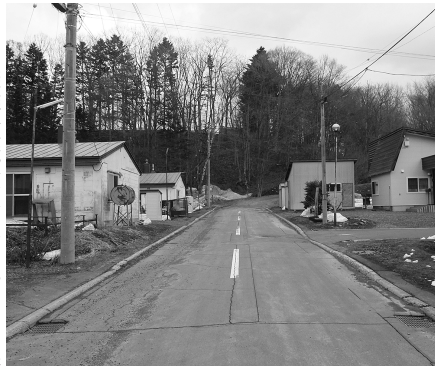
避難路建設が予定される宮下線
