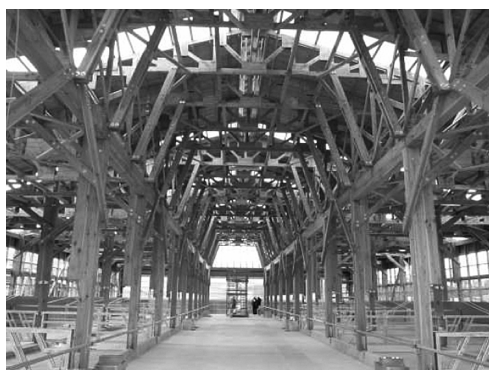
道産材を使用した牛舎の例
