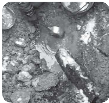
トムム診療所 灯油漏れ状況
