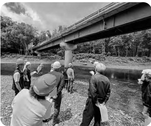
補修工事が進む占川橋
