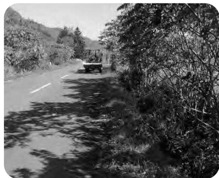
村道法面に生い茂るクルミの木
