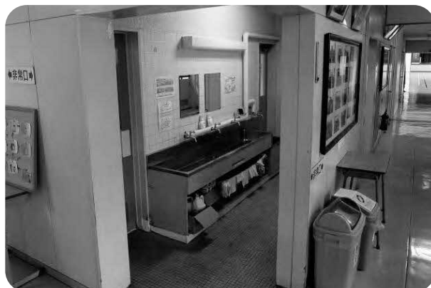
改修予定の占冠中学校トイレ
