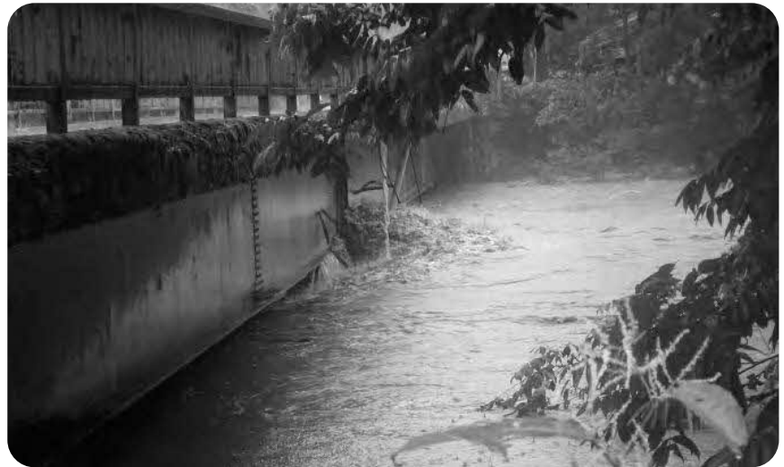
宝珠橋付近の増水状況
