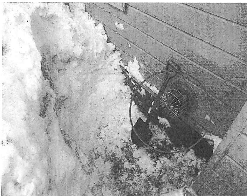
（給排気筒を除雪した状態）
