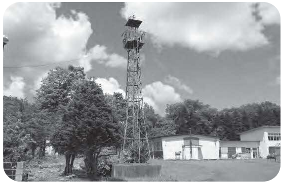
占冠地区サイレン塔
