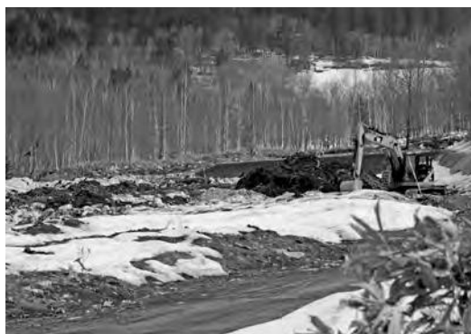
下トマム最終処分場
