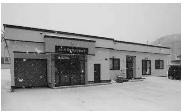
占冠駐在所(平成28年3月竣工)
