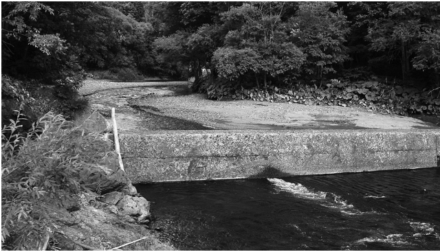
破損している鵒川の落差工
